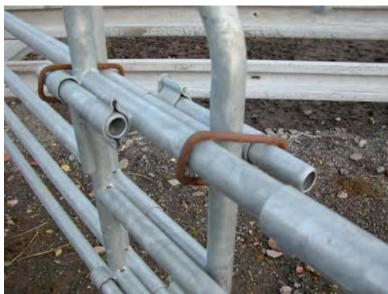
assemblage de deux barrières pivotantes
