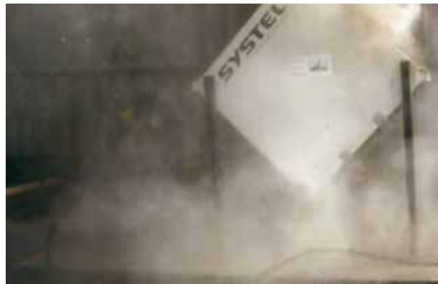
Dépeussierage d'un échangeur d'air
