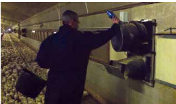
Époussetage de l'échangeur
