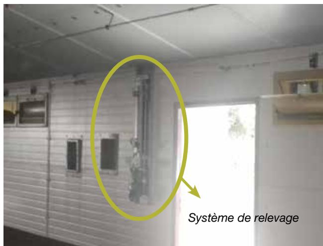
La mise en place de systèmes automatiques de relevage des lampes des trappes et chaînes d'alimentation permet de **supprimer l'utilisation de treuils manuels et donc les sollicitations du rachis**. Cela permet également de réaliser les opérations de maintenance au sol sans utiliser d'escabeau (changement des lampes).
