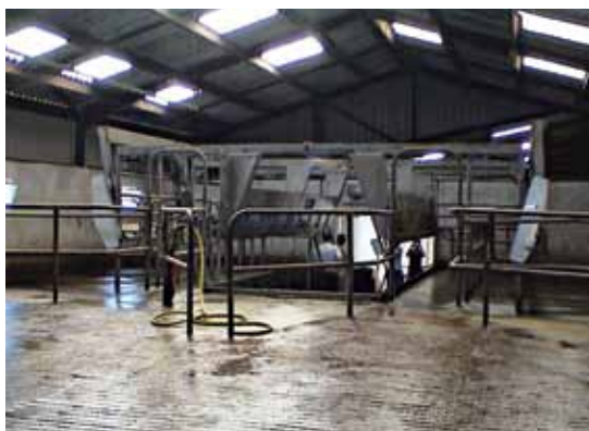
Salle de traite avec deux couloirs retour
