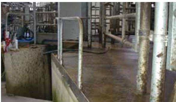
Un tunnel peut être prévu à la conception et permettre un accès rapide entre le poste de traite et la zone de sortie des VL en passant sous l'accès des vaches laitières (avec un éclairage adapté, des marches et sol antidérapants, un nettoyage et une évacuation des eaux facilités).
