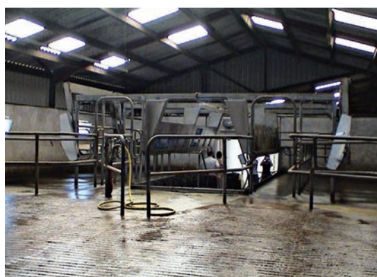
Salle de traite avec deux couloirs retour
