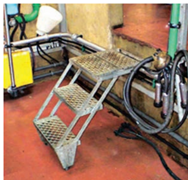
Escaliers avec des profondeurs de marches différentes
