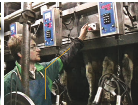
Barrière à commande automatique
