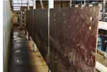
Parois pleines installées sur couloir de retour.
