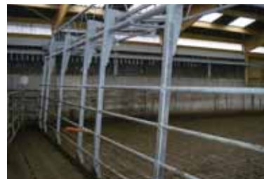
Barrières poussantes dans le parc d'attente
