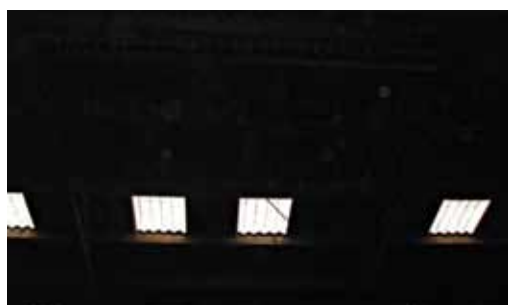
Translucides sur toiture
